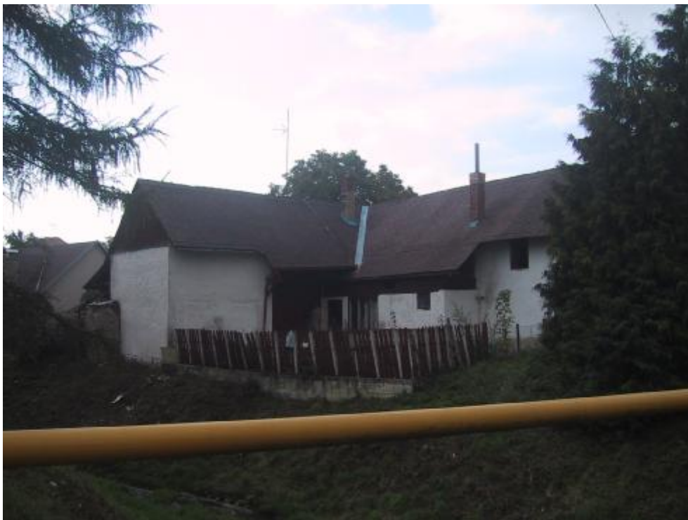
Pohled na dům ze dvora
