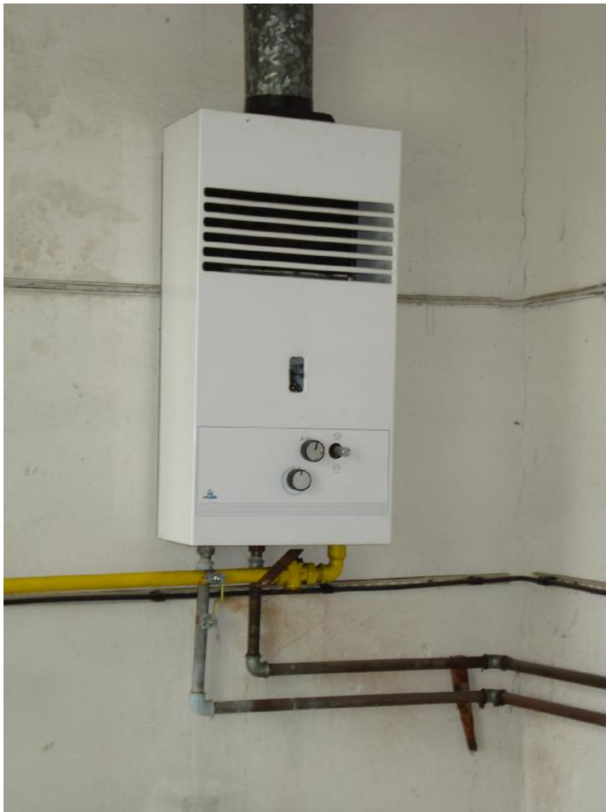
Plynový ohřev vody v sociální budově
