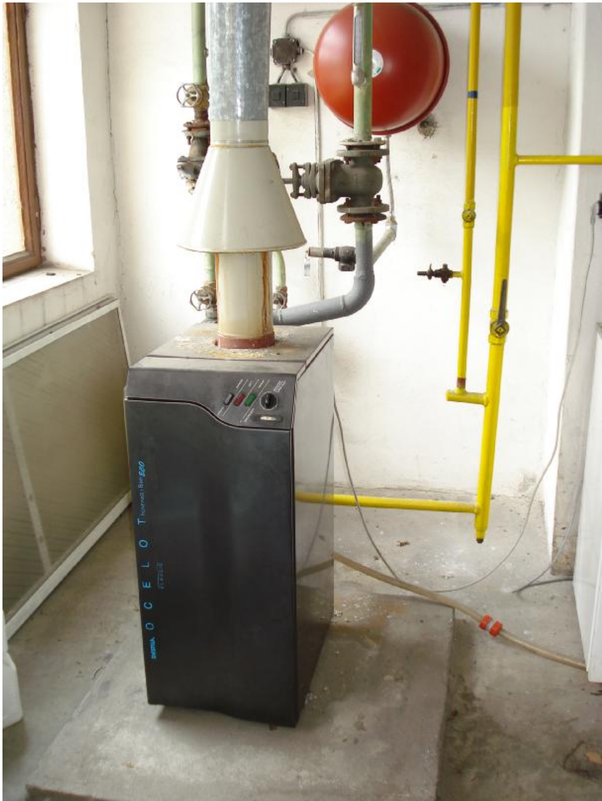
Plynový kotel pro vytápění sociální budovy
