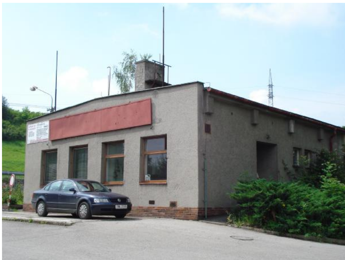
Sociální budova s mostní váhou u vjezdu
