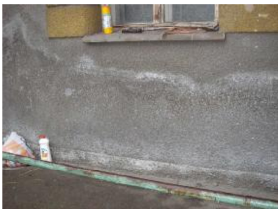
Solné výkvěty na fasádě – stavba je vlhká až do 1 m výšky místností
