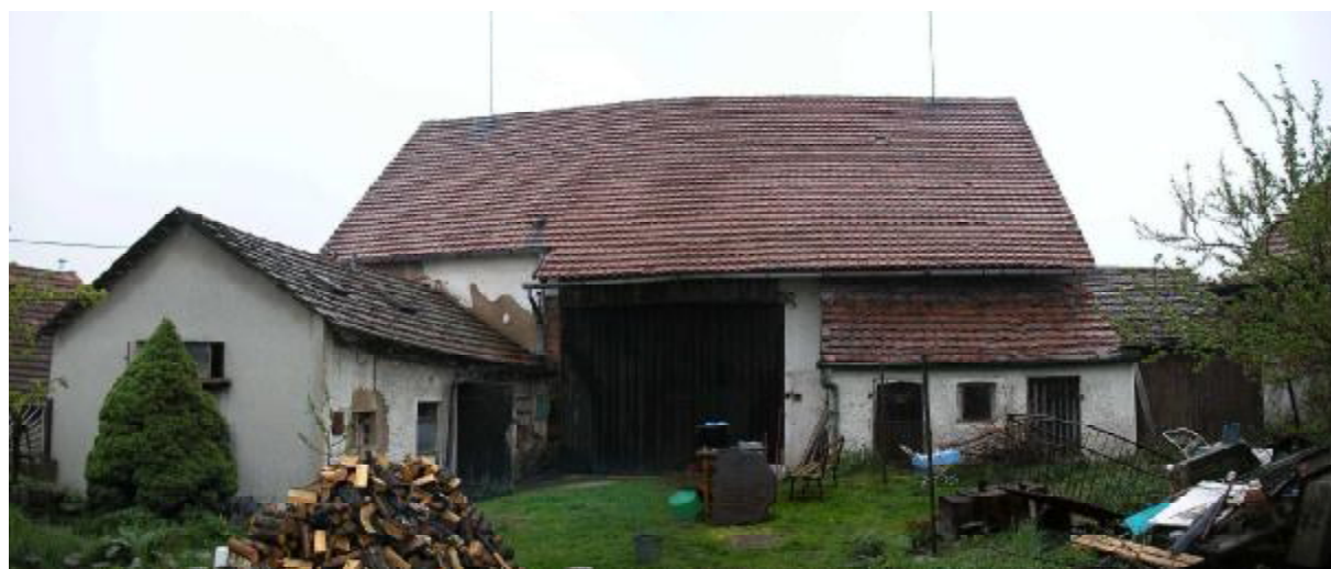
Hospodářské stavby v západní části areálu – stodola, 2 chlévy, kolna (východní pohled)
