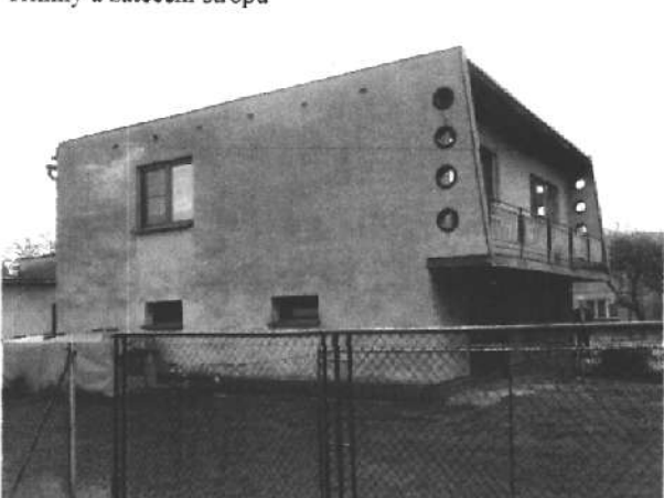
Pohled na RD ze severozápadní strany
