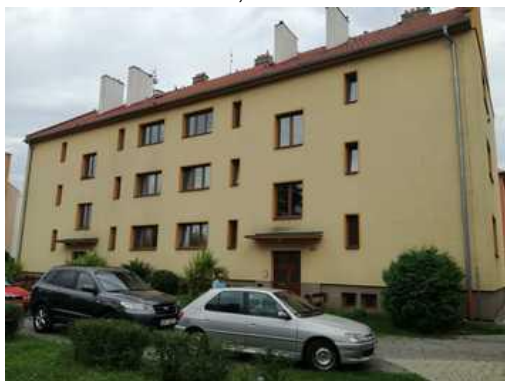
Bytový dům č.p. 961 - čelní pohled
