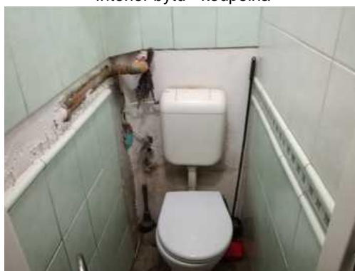
Interier bytu - WC
