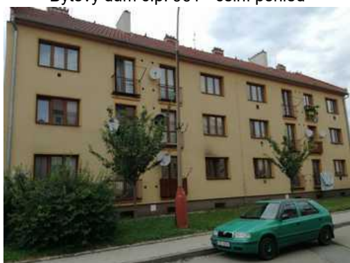
Bytový dům č.p. 961 - zadní pohled
