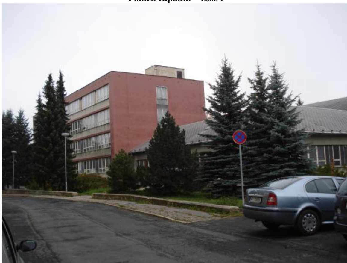
Pohled jižní – v popředí část 3 a dále část 1
