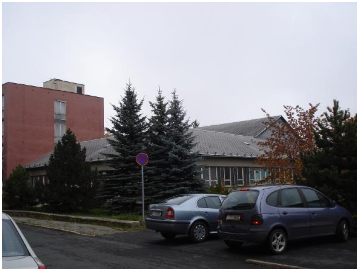
Pohled jižní - část 3
