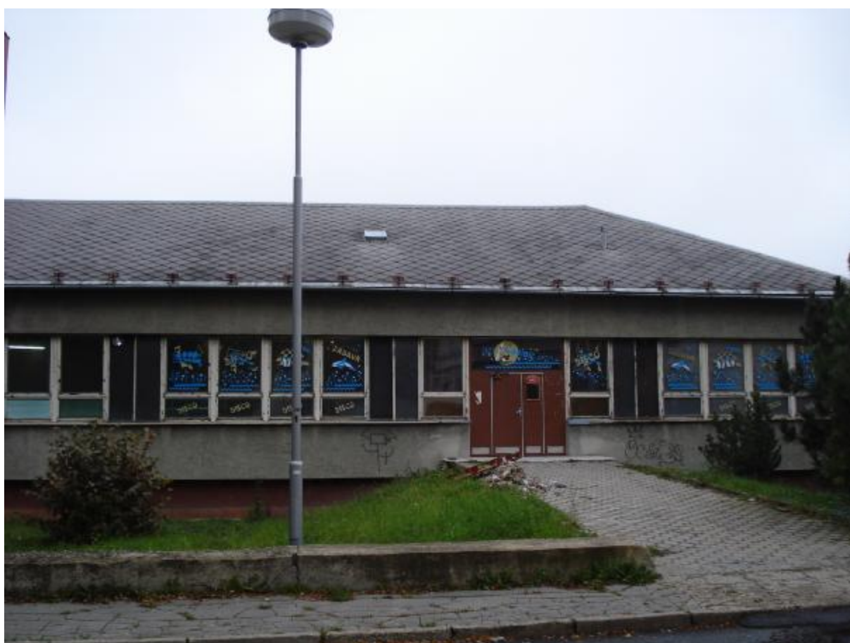
Pohled jižní – část 3
