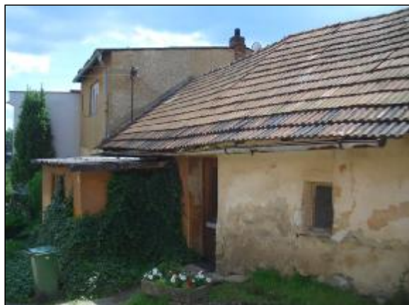
Pohled čelní - od severozápadu
