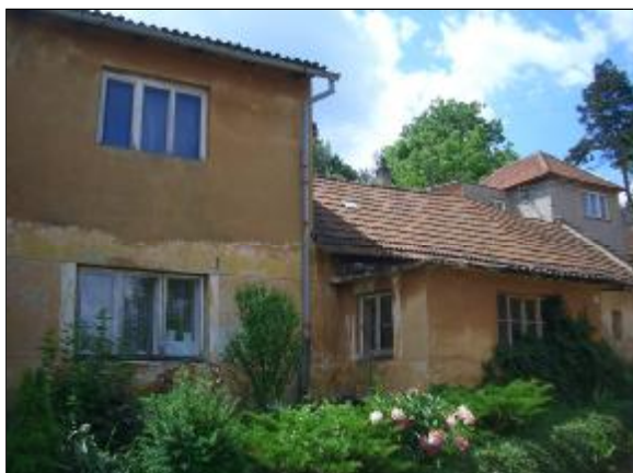
Pohled čelní - od severu
