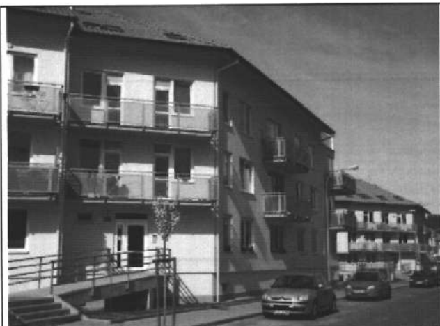
Pohled na byt.dům č.p. 615
