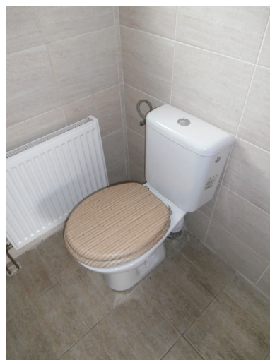
WC v tech. místnosti v 1.NP
