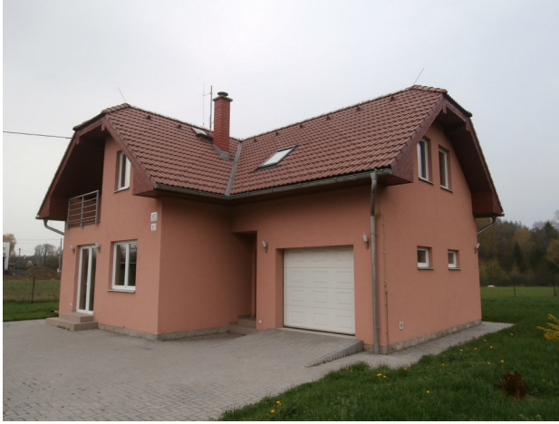
pohled na JZ a JV stranu
