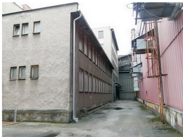
Rozvodna II. (vlevo) a soc.budova metalizovny (vlevo vzadu), vpravo hala lakovny
