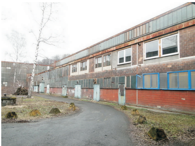
Přístavba u haly montovny I.
