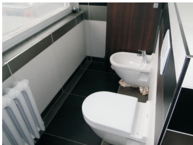
Administrativní budova č.p. 3267 (patro po rekonstrukci)
