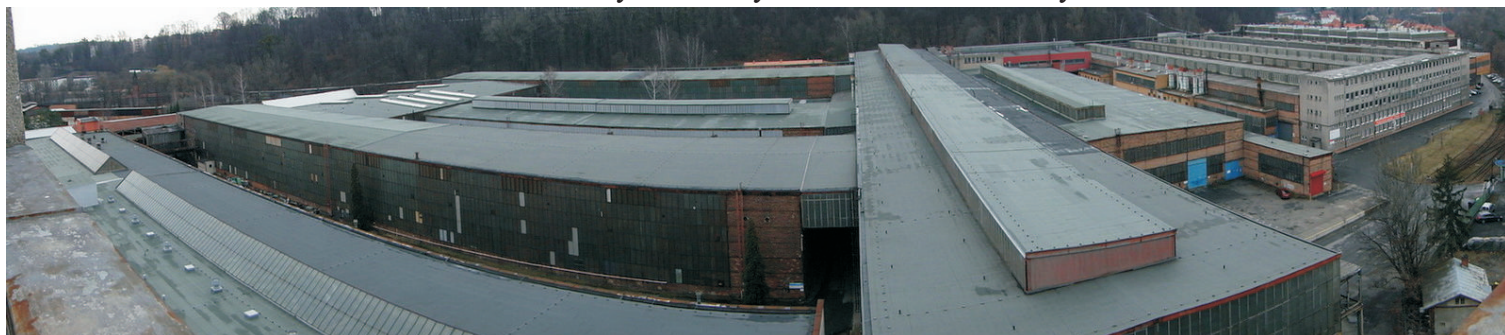
Pohled na haly ze střechy administrativní budovy
