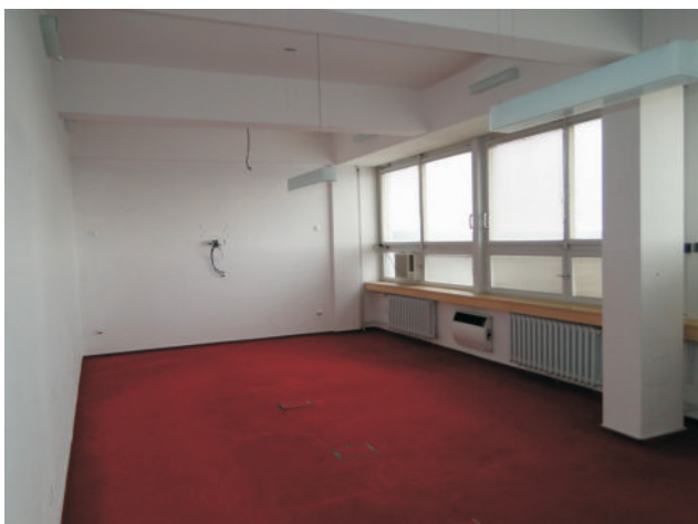
Administrativní budova č.p. 3267 (patro po rekonstrukci)
