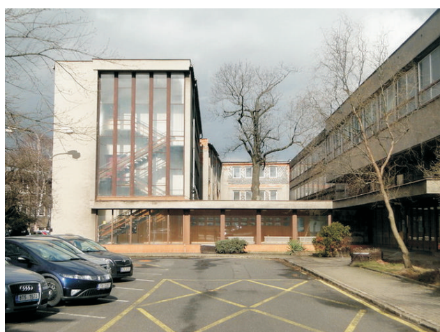
Budova konstrukčních kanceláří (vlevo) a spojovací krček
