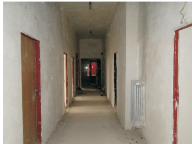
Budova konstrukčních kanceláří
