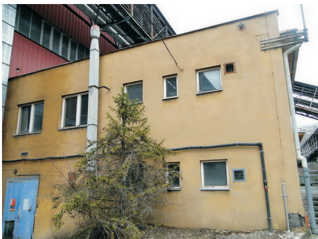
Budova RTG stanice
