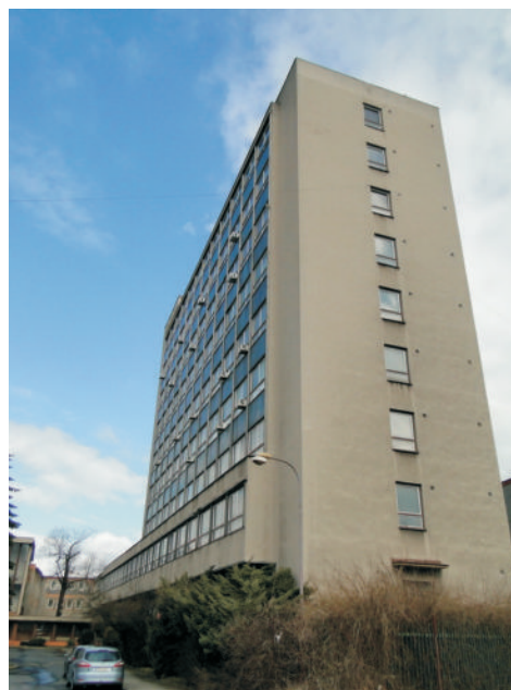
Administrativní budova č.p. 3267
